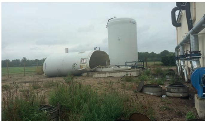
Explosion de la cuve de percolats sur un méthaniseur agricole.
