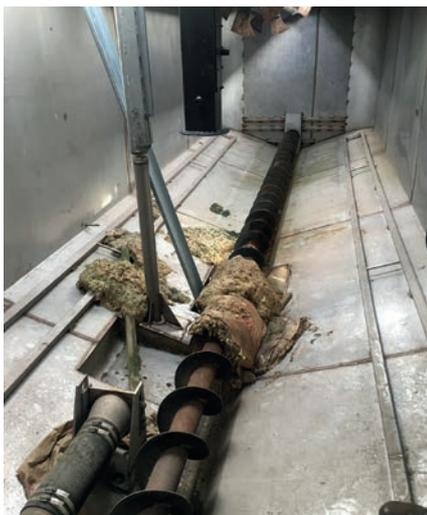
Vis d'incorporation et de mélange de capacité nettement insuffisante.
