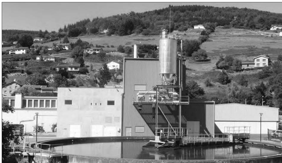
■ Depuis avril, la station d'épuration de Tarare est passée au compostage des boues. Photo d'archives Tatiana VAZQUEZ
