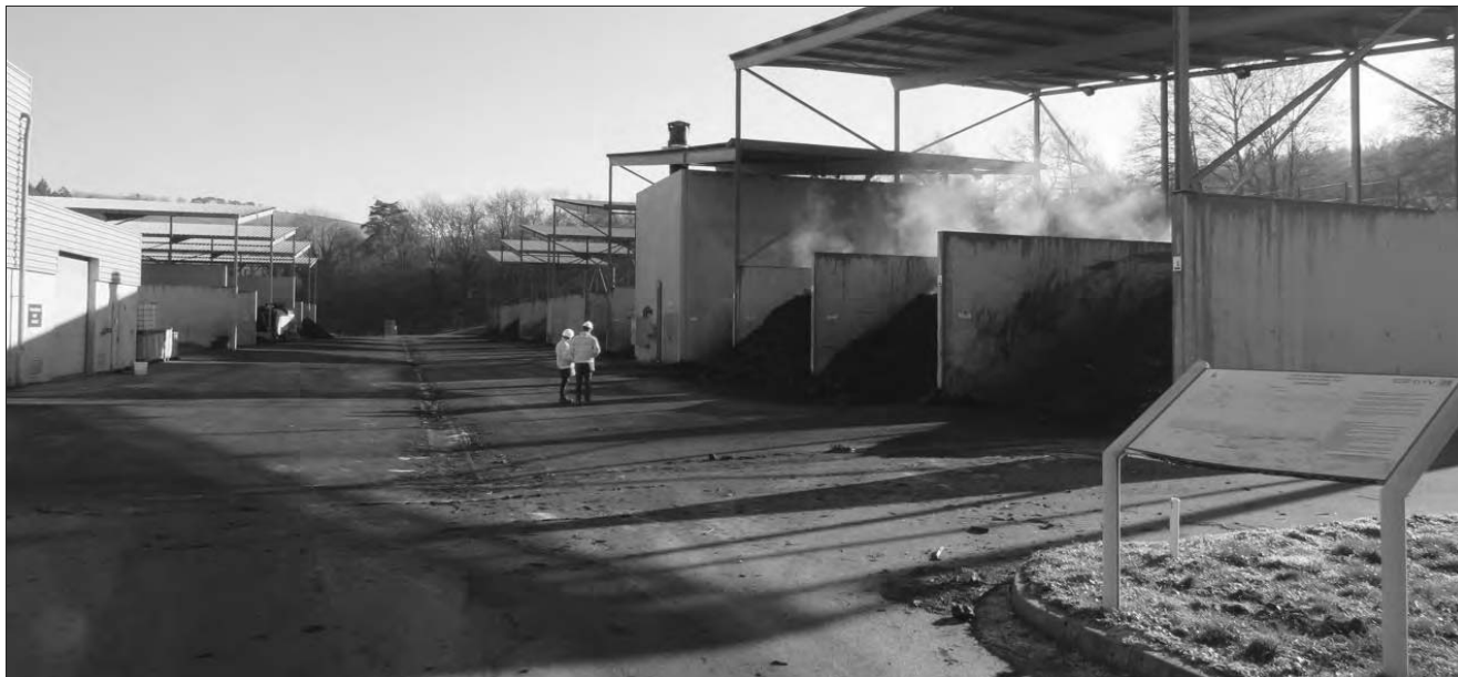
■ Huit casiers de fermentation aérée des boues pour une surface totale de 576 m 2 . Photo Annie GIRARD
