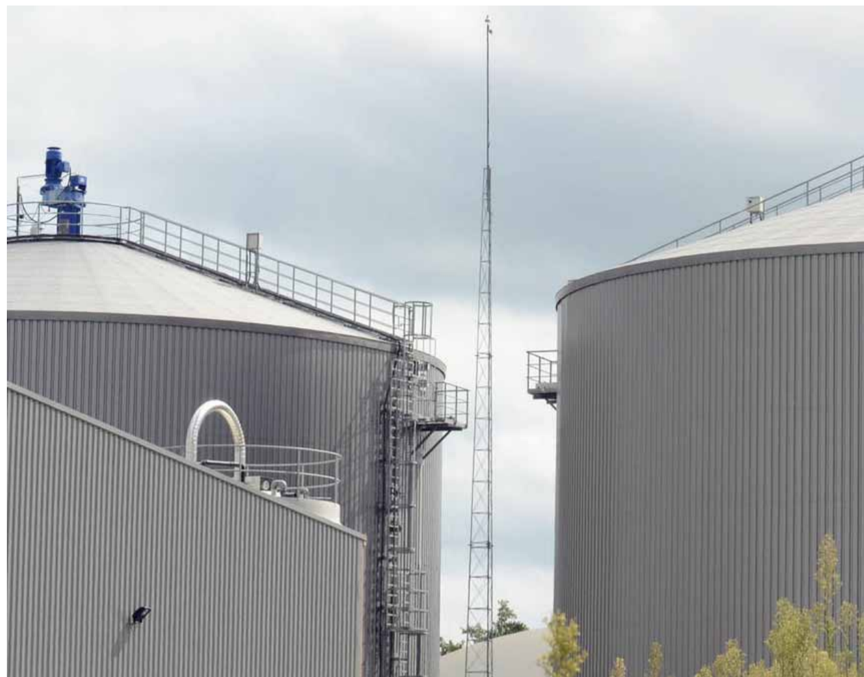
Les silos qui abritent les « digesteurs » des lisiers de canards gras, responsables du mauvais fonctionnement d'après ses constructeurs. PHOTO JEAN-LOUIS TASTET
